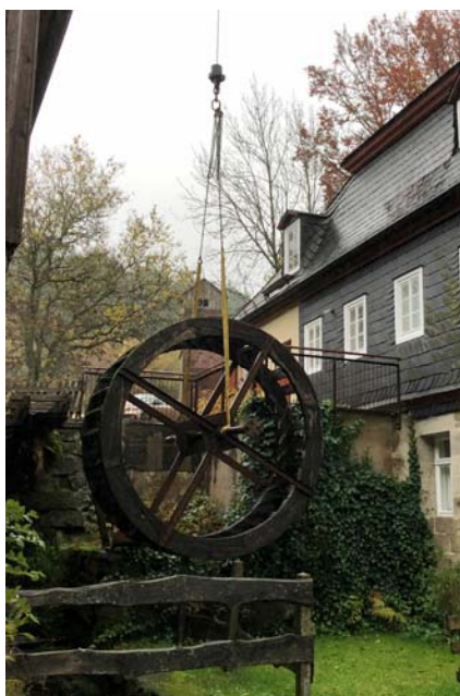
Das alte Mühlrad wird ausgebaut
